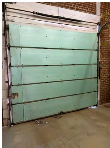
Garage Door Inside
