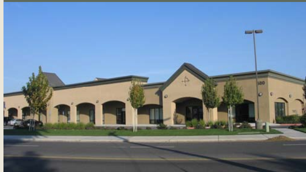
BUILDING B - 580 N. WILMA AVE.
