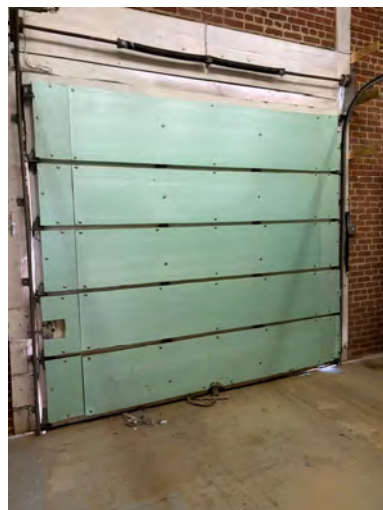
Garage Door Inside
