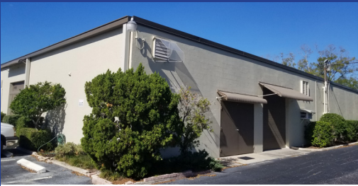
Unit G, SE Corner
